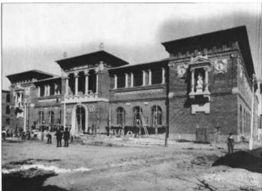
Fachada principal del Edificio de Museos. Estado de las obras en 30 de abril de 1908.
