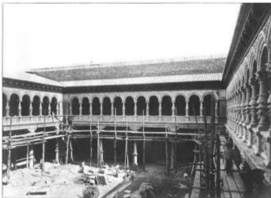
Patio del Edificio de Museos. Estado de las obras en 30 de abril de 1908.
