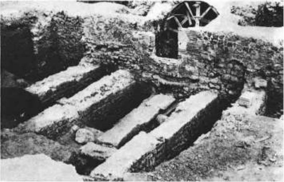
LÁM. 1. Anfiteatro romano, sector sur (1967). Muro perimetral con contrafuertes, acceso abovedado, muros radiales externos, canal de desagüe central cubierto con losas, bajo el acceso. Conservado «in situ».
