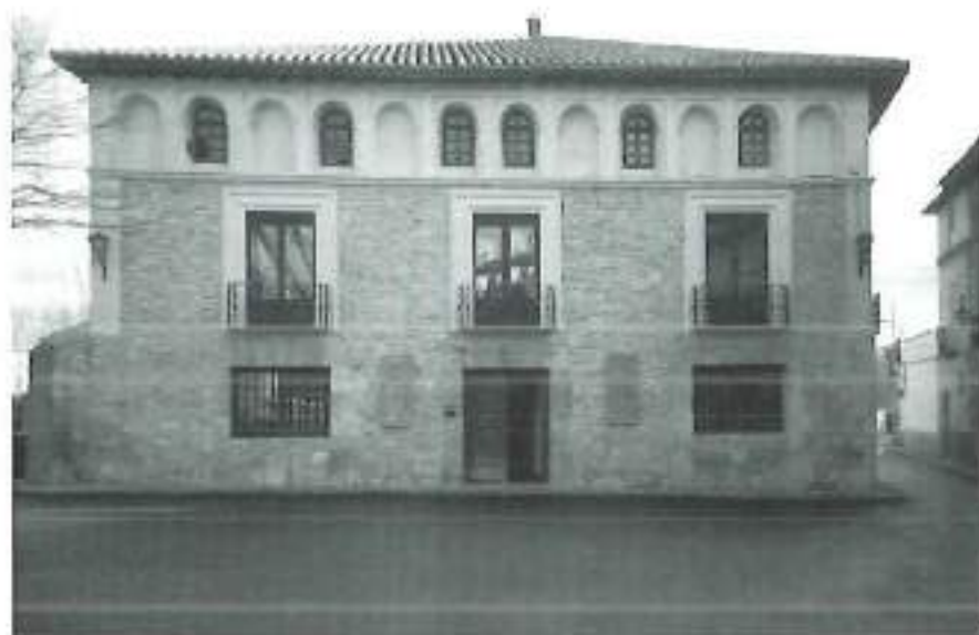
Fig. 2. Fachada de la Casa de Cultura de Monreal del Campo.
