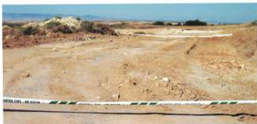
Figura 30. Vista de un tramo del nuevo camino realizado en la concentración parcelaria de Magallón, con las señales de la Guardia Civil correspondientes a una de las áreas destruidas por las obras en la necrópolis de Carraveruela (Foto: Royo, 2005).
